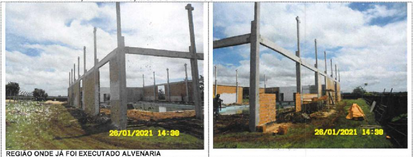
REGIAO ONDE JÁ FOI EXECUTADO ALVENARIA
