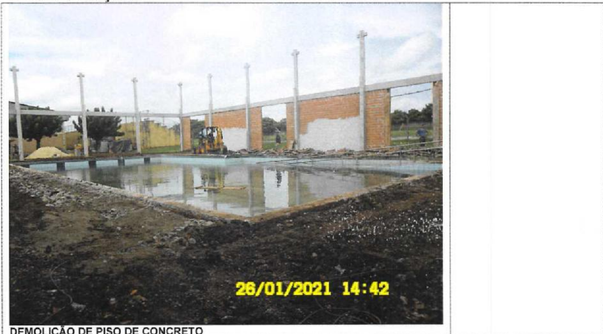
DEMOLIÇÃO DE PISO DE CONCRETO
