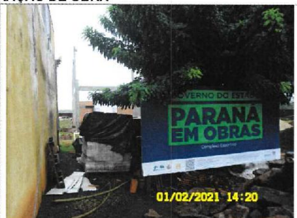
PLACA DE OBRA PRESENTE NA OBRA
