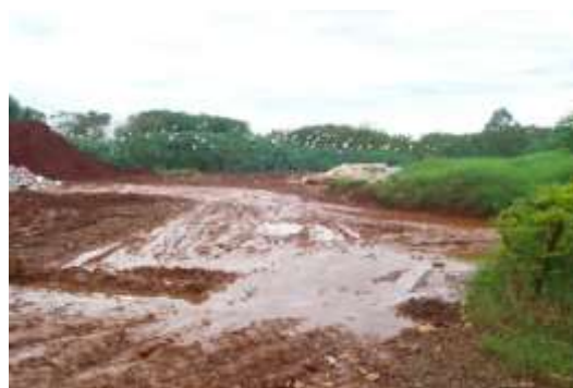
Aterro Controlado (valas)
