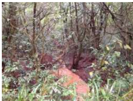
Trecho a montante da estrada rural
