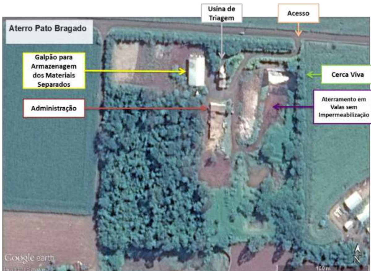
Figura 75 - Aterro Controlado de Pato Bragado
