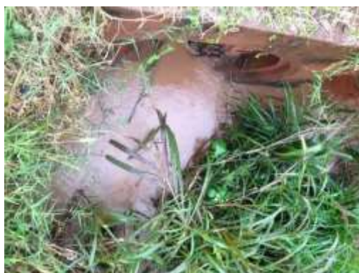
Tubulação a montante da PR-495
