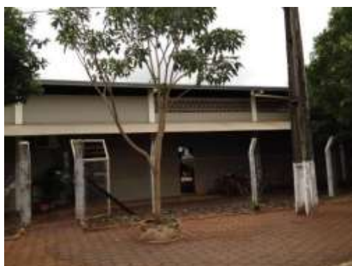
Prédio da Sec. de Obras
