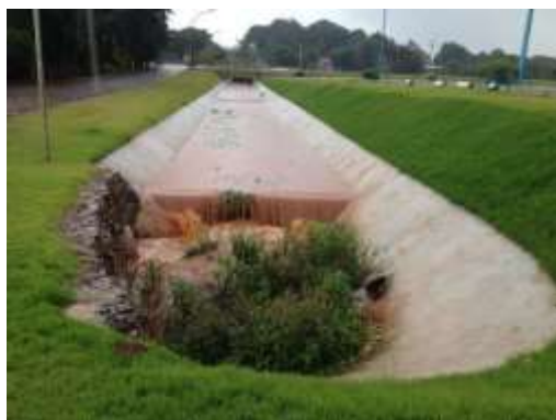
Canal de drenagem de concreto – Lago Municipal
