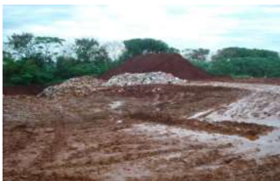
Aterro Controlado (valas)
