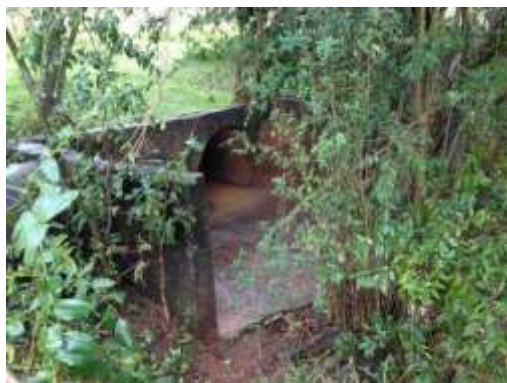
Proteção de concreto do desemboque
