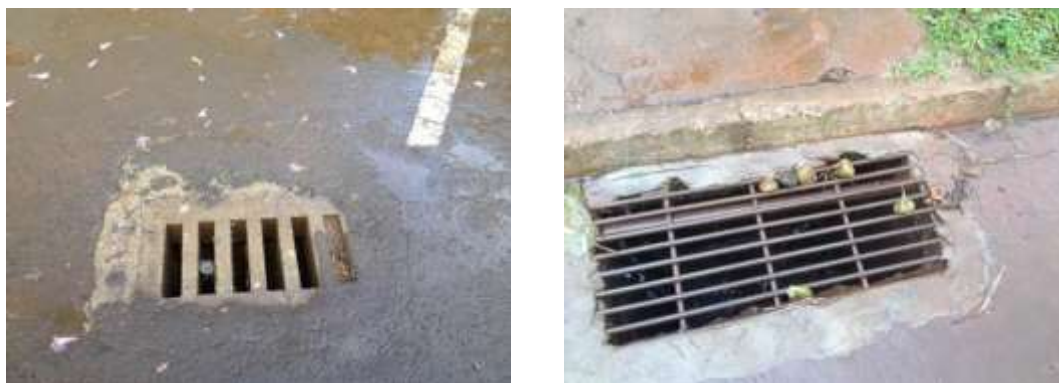
Figura 51 - Diferentes tipologias de bocas de lobo encontradas no município de Pato Bragado. Fonte: CEPMSB, 2015.
