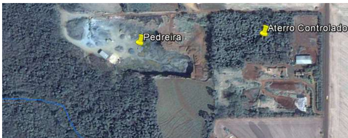
Rio Arroio Fundo (esquerda), Pedreira (centro) e Aterro Controlado (direita) – Imagem de 2013
