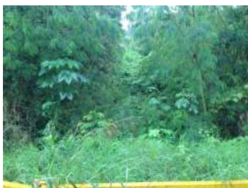
Tubulação a montante da Av. Continental
