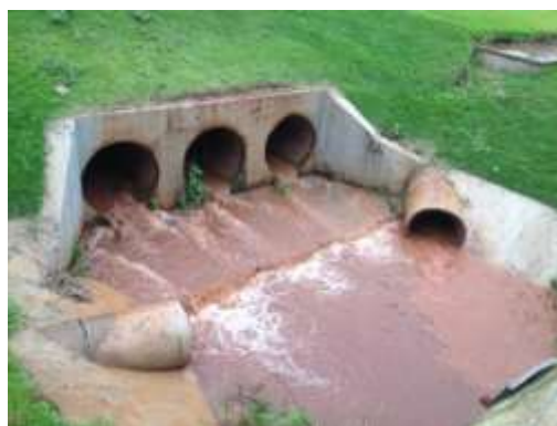
Tubulações de microdrenagem a jusante da PR-495
