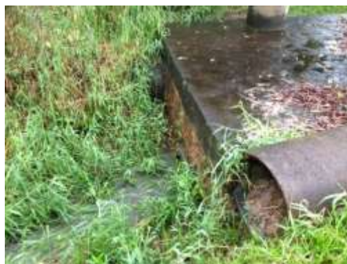
Detalhe da Caixa – montante da Av. Continental
