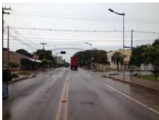
Via asfaltada no Centro
