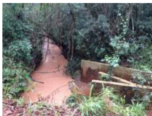
Sanga a jusante com estrutura dissipadora
