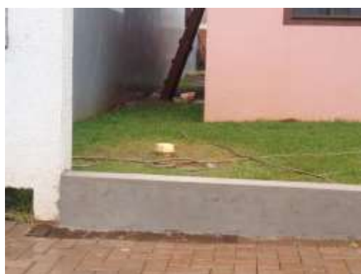
Fossa Séptica na frente da residência
