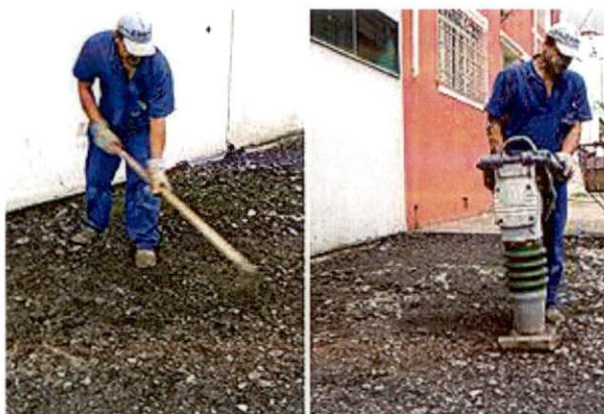
Figuras 1 e 2: Nivelamento e compactação sub base e base.
