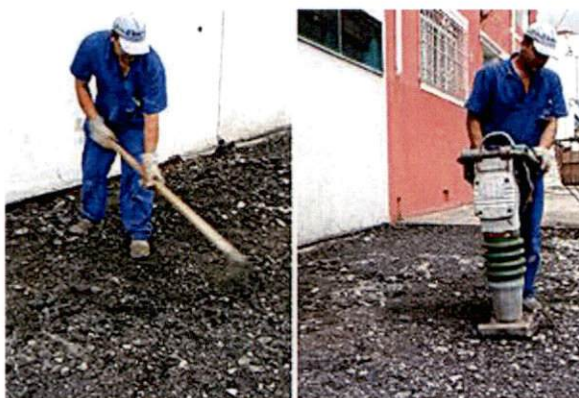
Figuras 1 e 2: Nivelamento e compactação sub base e base.
