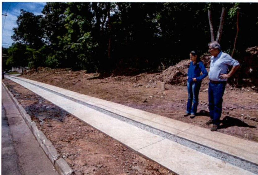
Figura 3: Calçada em concreto desempenada, com espaço disponível para instalação do paver tátil direcional e alerta.
