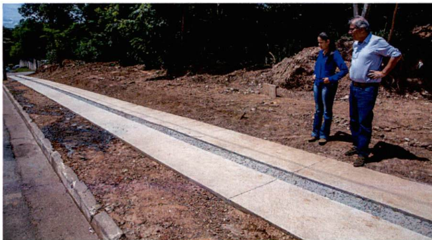
Figura 3: Calçada em concreto desempenada, com espaço p/ instalação do paver tátil direcional e alerta.
