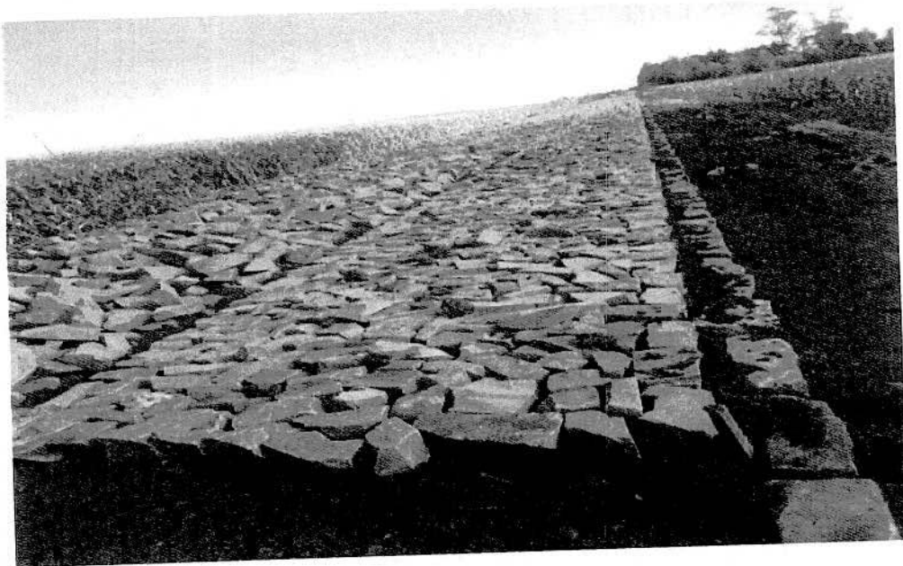
Figura 3: Assentamento de Pedras Irregulares
