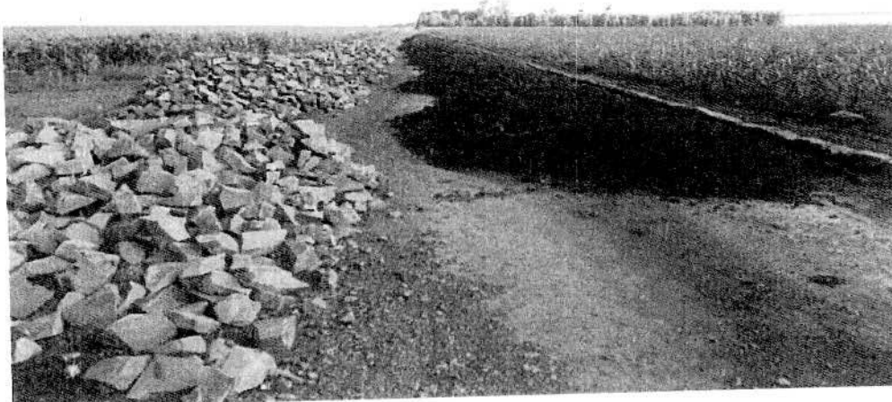
Figura 2: Compactação, nivelamento para assentamento de pedras irregulares
