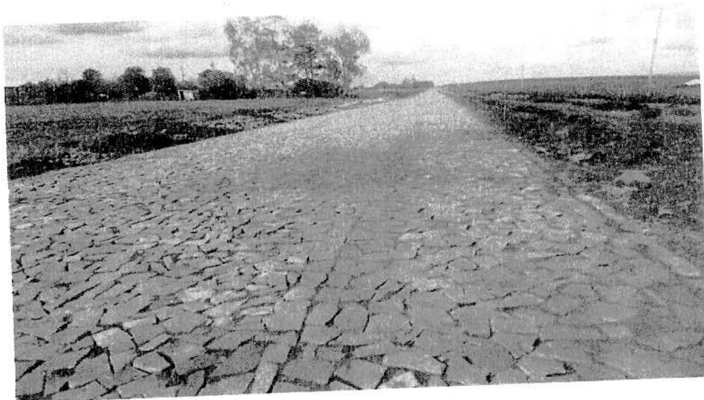
Figura 4: Faixa de Rolamento com Pedras Irregulares Assentadas e Regularizadas
