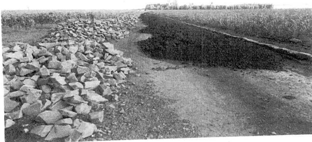
Figura 2: Compactação, nivelamento para assentamento de pedras irregulares
