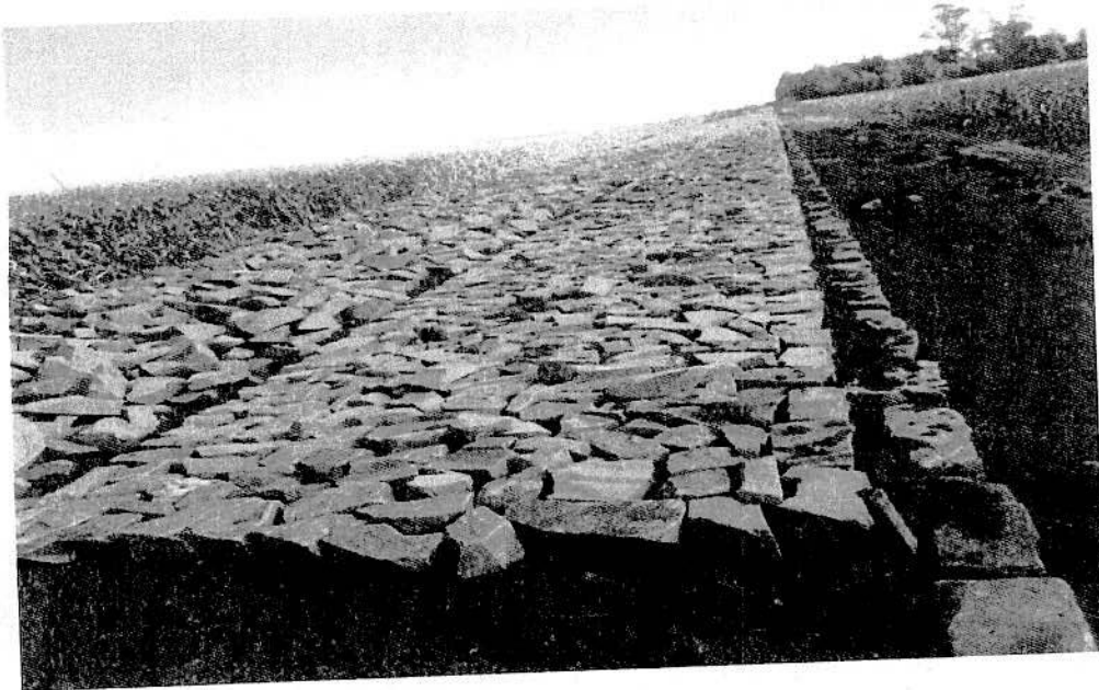
Figura 3: Assentamento de Pedras Irregulares
