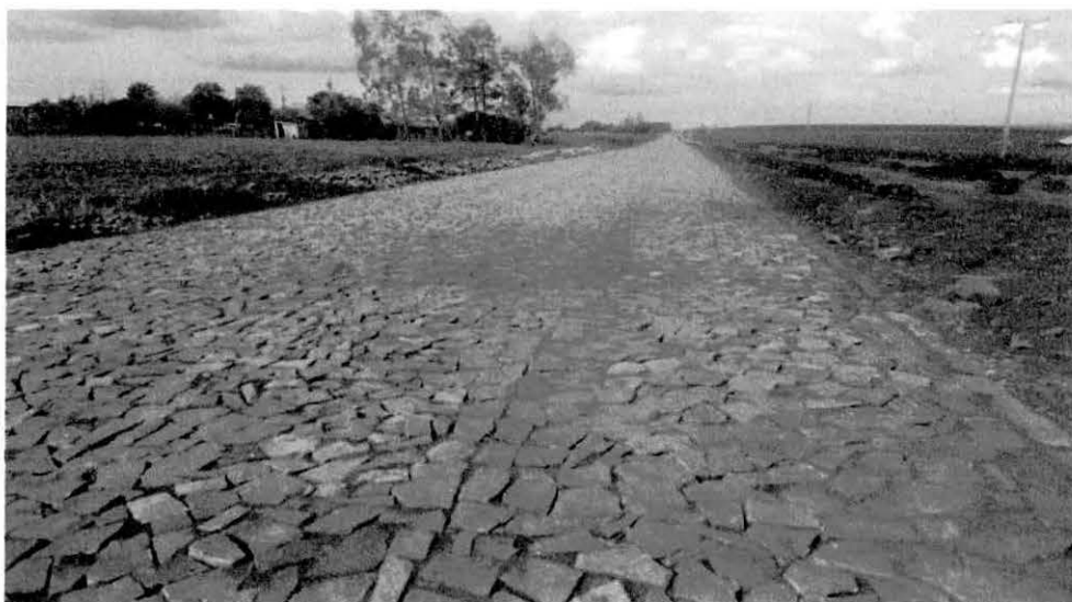
Figura 4: Faixa de Rolamento com Pedras Irregulares Assentadas e Regularizadas
