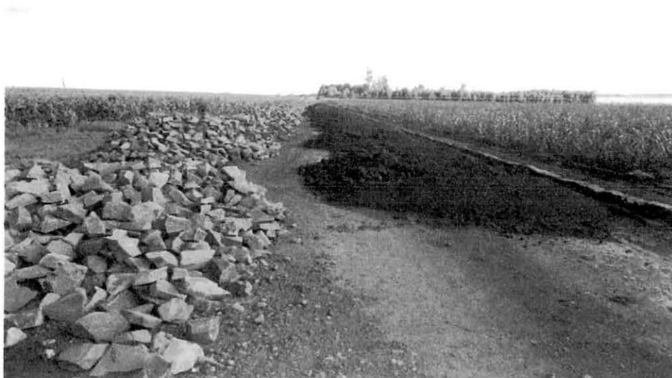
Figura 2: Compactação, nivelamento para assentamento de pedras irregulares
