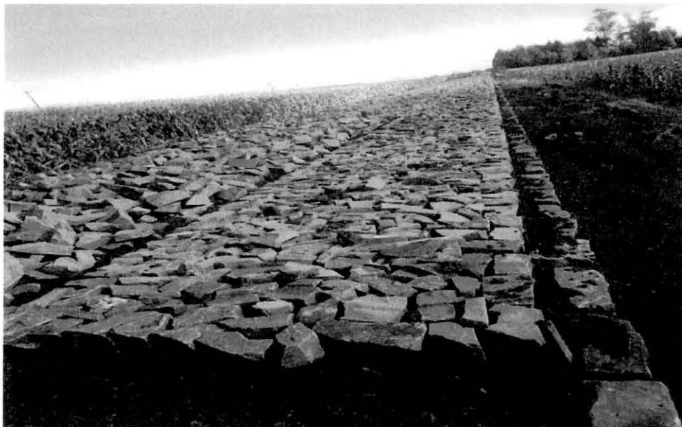
Figura 3: Assentamento de Pedras Irregulares
