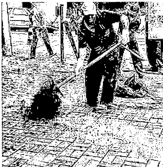
Figura 10: Rejunte dos blocos
