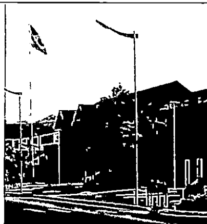
Poste da Av. Willy Barth
