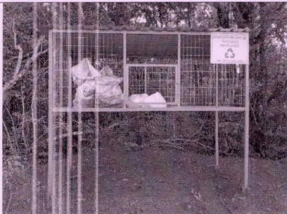
PEV/CASINHA: Telha soldada 5x5mm x 2,00mm. Portinha de 1,80cm de altura por 1,0m de largura com duas dobradiças gonzo e porta cadeados. Tela malha de 5x5mm x 2,00mm. Cobertura com bordas sobressalentes com chapa de zinco 0,50, nas medidas de 2,20m x 1,20m (2,64m<sup>2</sup>). Estrutura de ferro em tubo retangular 30x40x18. Pés com 0,80cm de altura. Com pintura epóxi cor a escolher pela contratante.
